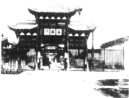
▲清代两江总督署东、西辕门。太平天国曾以督署扩建为天王府，天京城破时被毁。同治年间重建（1889年摄）
