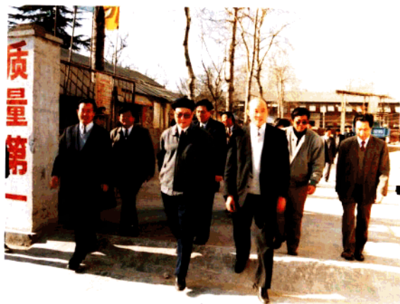
1996年底，中共山东省委书记、 党校校长赵志浩（前右2）来校视 察教学大楼建设工地。
