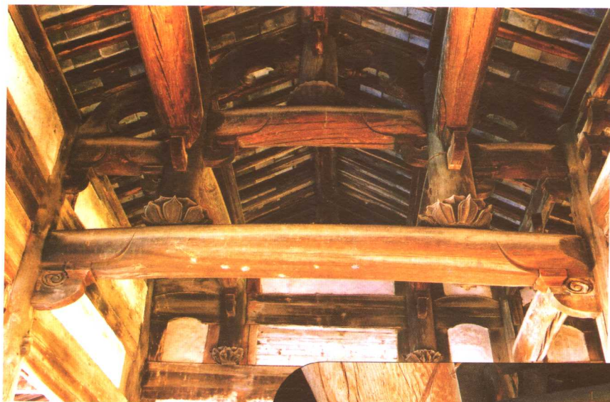
彩图7 黟县万村明代爱敬堂梁架粗硕，丁头拱为托架，丁头拱眼雕花；梁上平盘斗雕如荷花；檩间叉手、托脚反曲如弓，造型壮硕。
