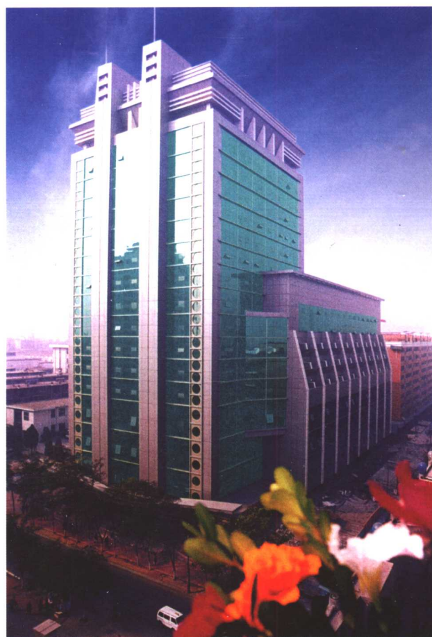
属地化管理以来，甘肃省地矿局在加强管理的同时，注重地矿队伍建设，队伍的精神面貌和地勘单位的整体形象焕然一新。图为拔地而起的甘肃地矿大厦全景
