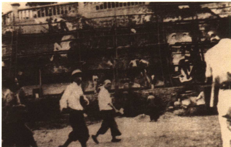
正在绘制中的武汉黄鹤楼大壁画 1938年
