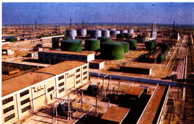
亚洲最大的原油 输送站孤东联合站
