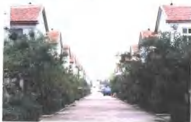
北马道危房改造区
