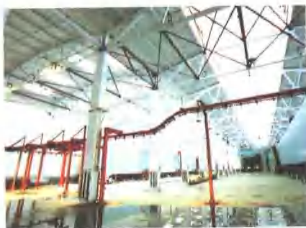
具有全国先进水平的新涂装车间
