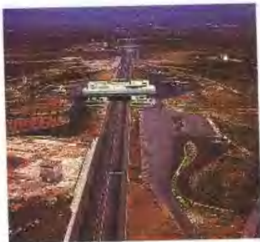
正在建设中的高速公路。
