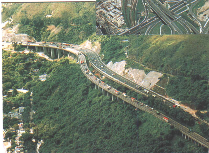
▶ 香港第一条快速公路—— 屯门公路, 1984年开通 (The Tuen Mun Road)
