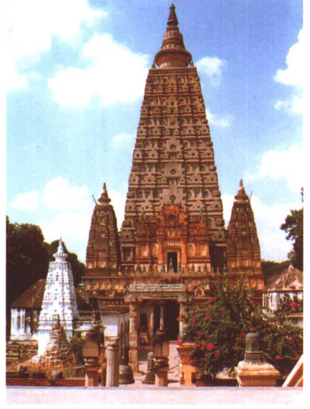
印度佛陀伽耶大塔
