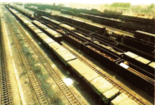
胶济铁路城阳火车站
