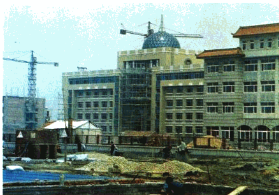
建设中的城阳区行政中心。
