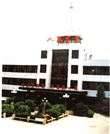
县供电局办公大楼
