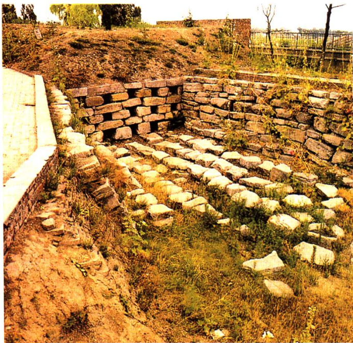
临淄·齐故城排水 水道口遗迹
