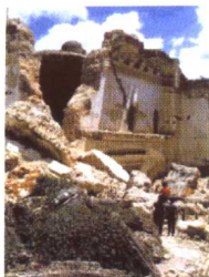
在1988年亚美尼亚的列宁纳坎市地震中倒塌的建筑
