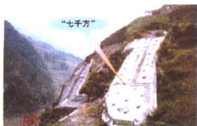
经过锚固的“七千万”岩体
