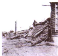
台湾省嘉义郡水上庄火车站附属仓库向东南方倒塌
