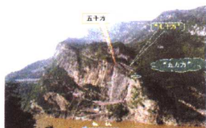
长江三峡地区主要滑坡点
