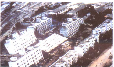
日本新潟地震因为土壤液化，导致建筑物倾倒
