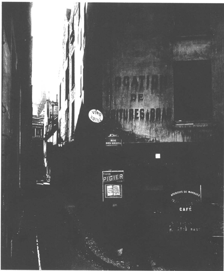
1793 年建造的房子 1907
