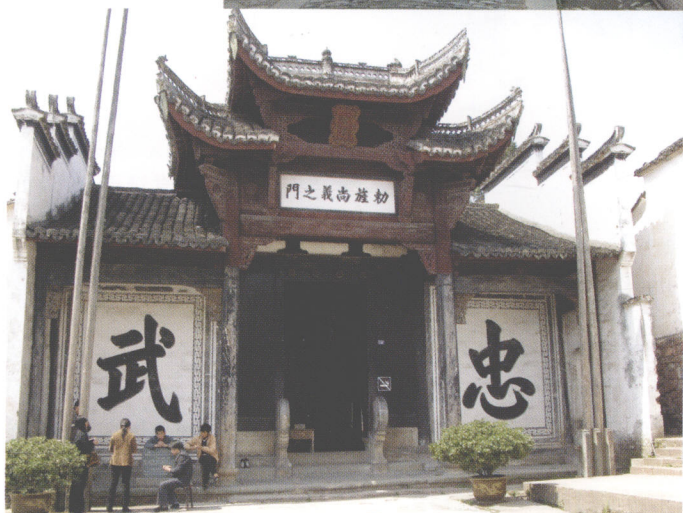
浙江兰溪 诸葛镇诸葛祠堂
