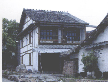
浙江永嘉岩头镇 苍坡村古村落内 外立面整治过的建筑
