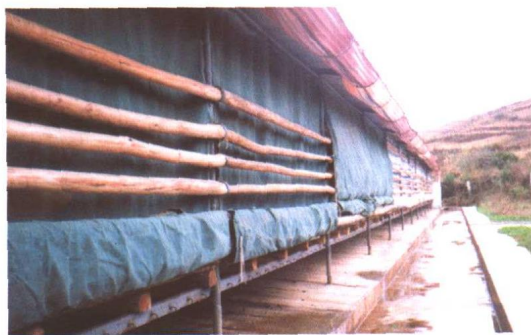
漏缝地板式羊舍(背面)
