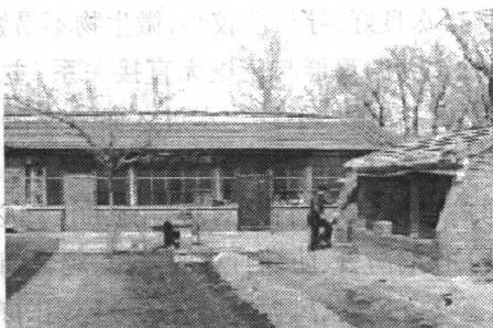
图6 利用庭院空余房舍改造成的鸡舍
