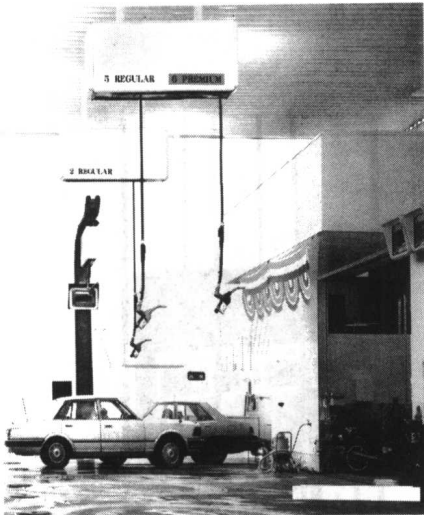
图 1-5 悬挂无岛式加油系统
