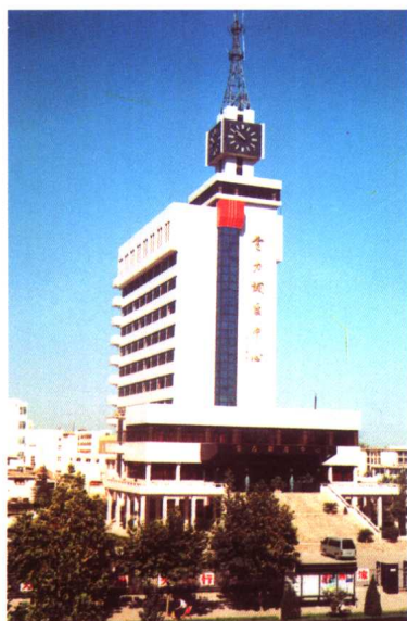
电力调度中心。
