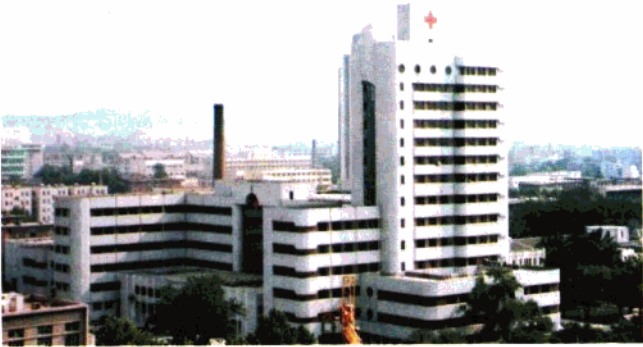
正在施工的保健病房大楼（模型）
