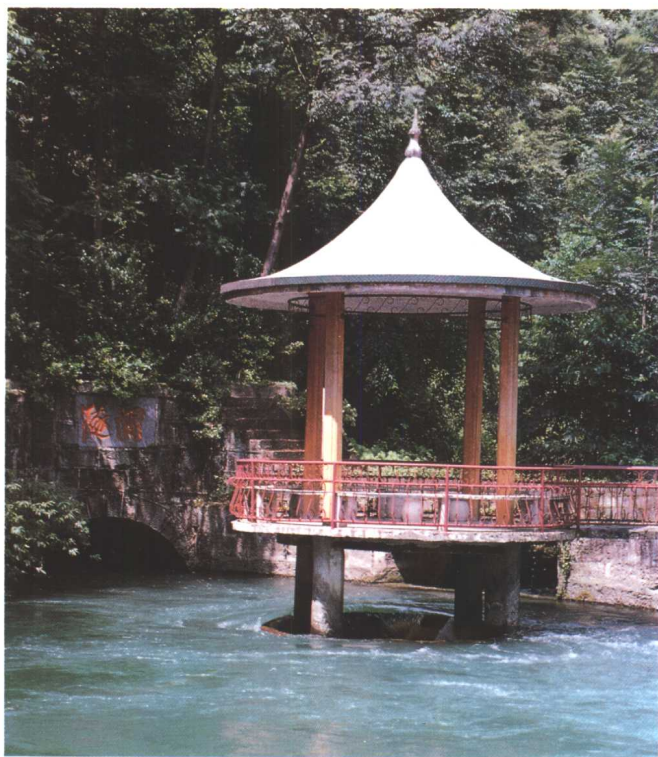
江口王家山电站前池竖井溢流。
