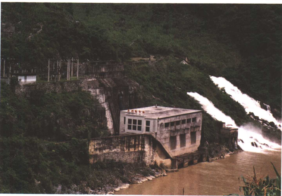
罗甸县石门坎电站全景。
