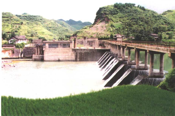
玉屏马面坡电站。
