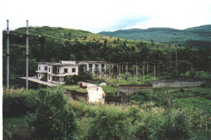
瓮安天文变电站。
