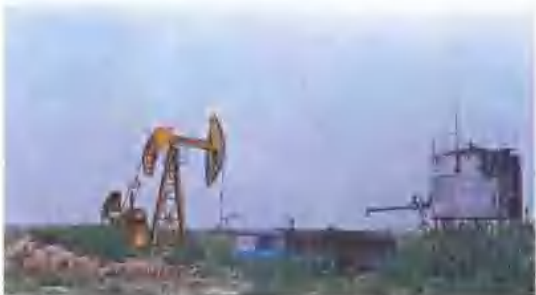
县境油区作业的提油机和贮油罐群
