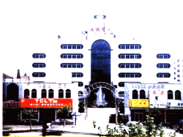
◀县广播电视大楼
