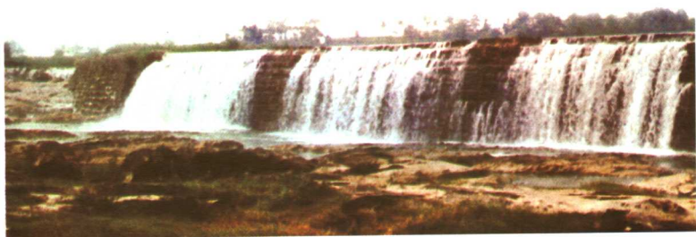
唐代筑堰引水工程—崇阳石枧堰
