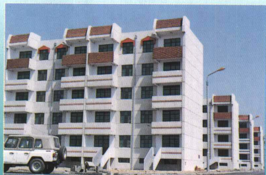
提前一年完成的“安居工程”住宅楼
