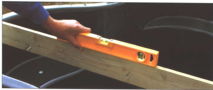
上图：在建设一个池塘的工作中，最重要的目标是让它平整。特别是在安装坚硬的外壳时，要使用一个可靠的水平仪和直尺。
