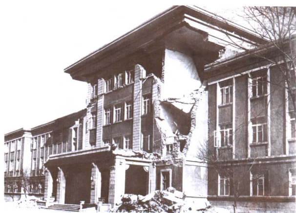
1975 年辽宁海城 7.3 级地震，海城县招待所 主楼部分倒塌
