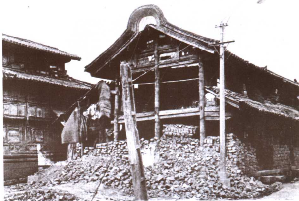
1976 年云南龙溪 7.4 级地震，施甸县城关民房 土坯墙倒塌
