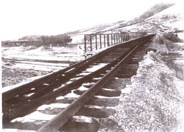
1975 年辽宁海城 7.3 级地震，海城县英落公社 赵家堡西河铁路桥铁轨呈波浪状变形
