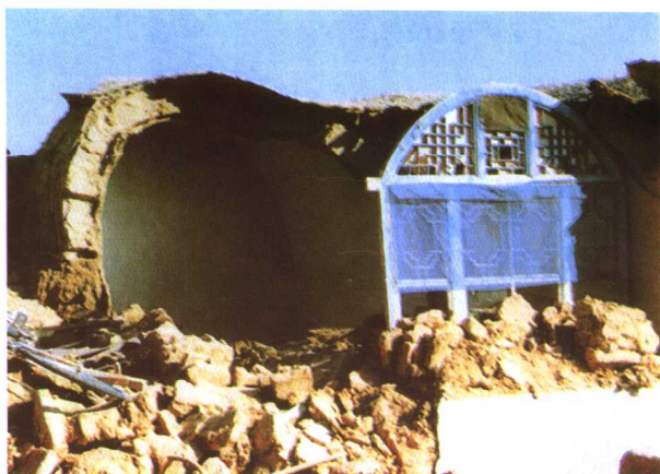
1989 年山西大同 - 阳高 6.1 级地震，窑洞倒塌
