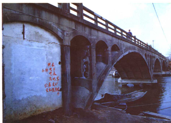
1990 年江苏常熟 - 太仓 5.1 级地震，引桥填冲墙裂缝
