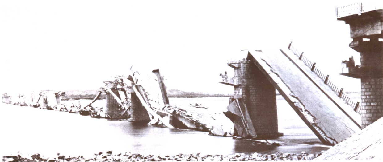
1976 年河北唐山 7.8 级地震，滦河大桥倒塌
