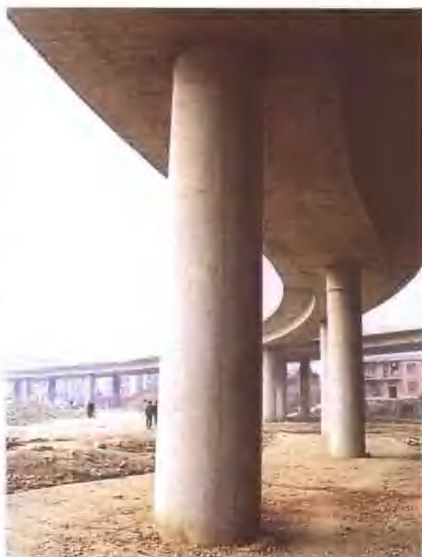
二处施工的岳阳瑟琶王立交桥。 (王福生摄)
