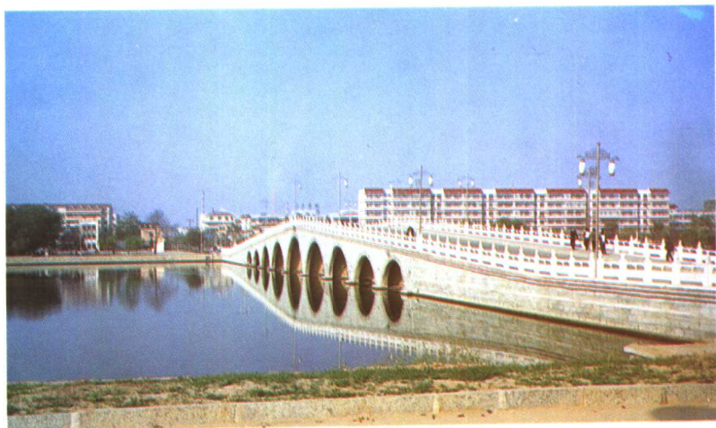
玉带浮水化为桥
