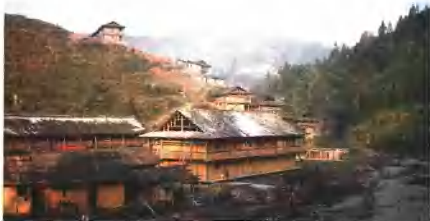
依山傍水的大小木楼，坡顶上前有红旗者是加两小学。
