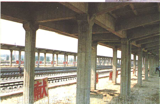
建设中的火车站 The Railway Station (Being Built)
