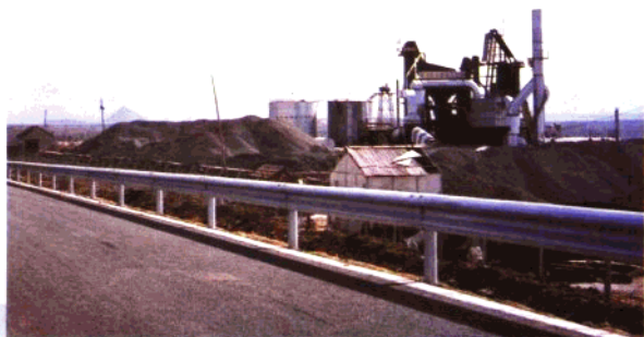
与博莱路为 邻的莱芜市公路 局工程处沥青拌 合厂
