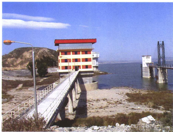
汾河水库进水塔
