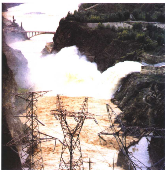
黄河大北干流天桥水电站
