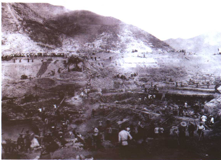
横锦水库施工场面之二
