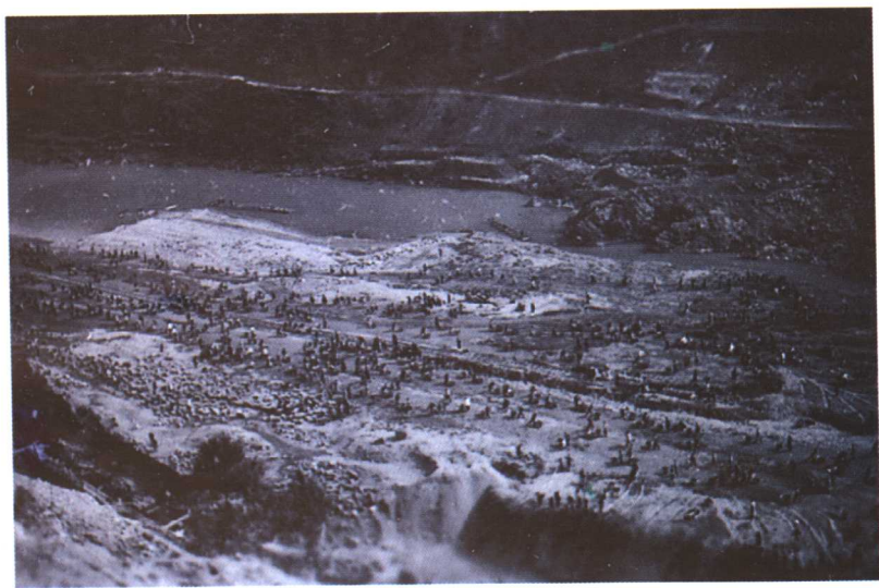
横锦水库施工场面之四
