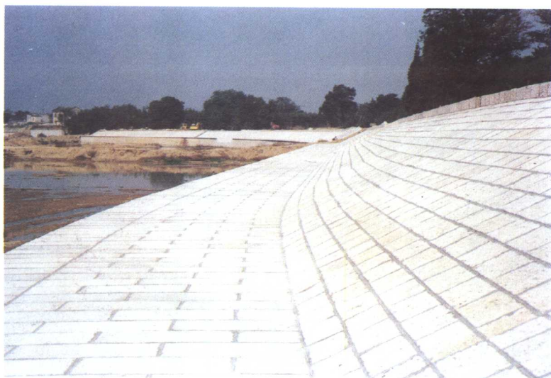
已竣工的城市防洪工程一景
