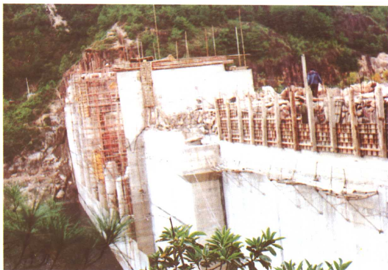
南江水库加高加固工程施工
