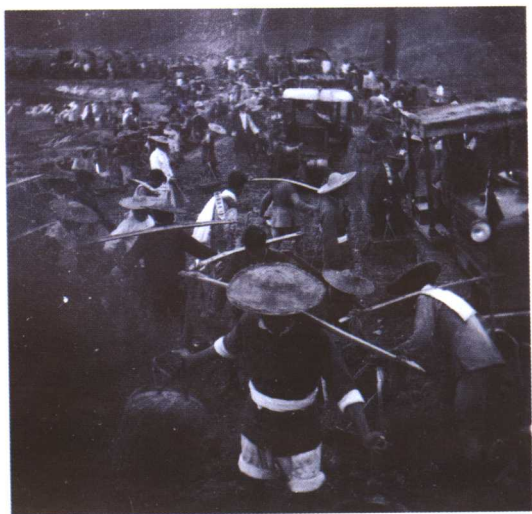
横锦水库施工场面之三
