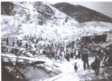
横锦水库工地心墙夯土大会战
