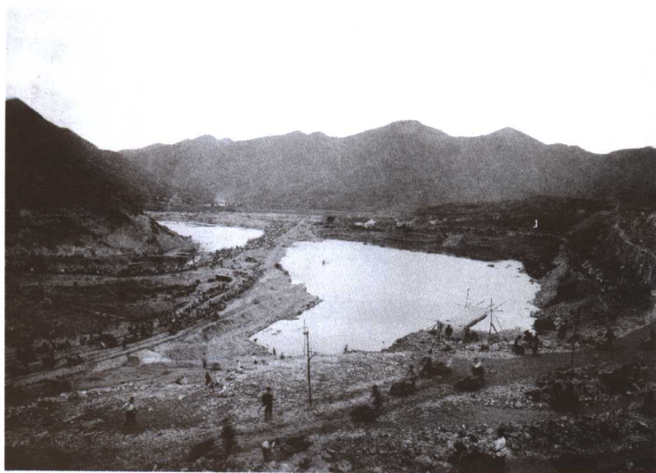
横锦水库施工场面之一
