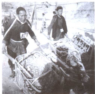
横锦水库工地拉车比赛现场
