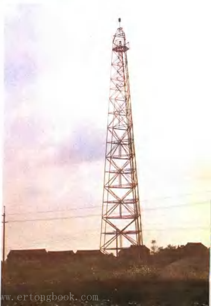
新寺镇西南侧航标塔
