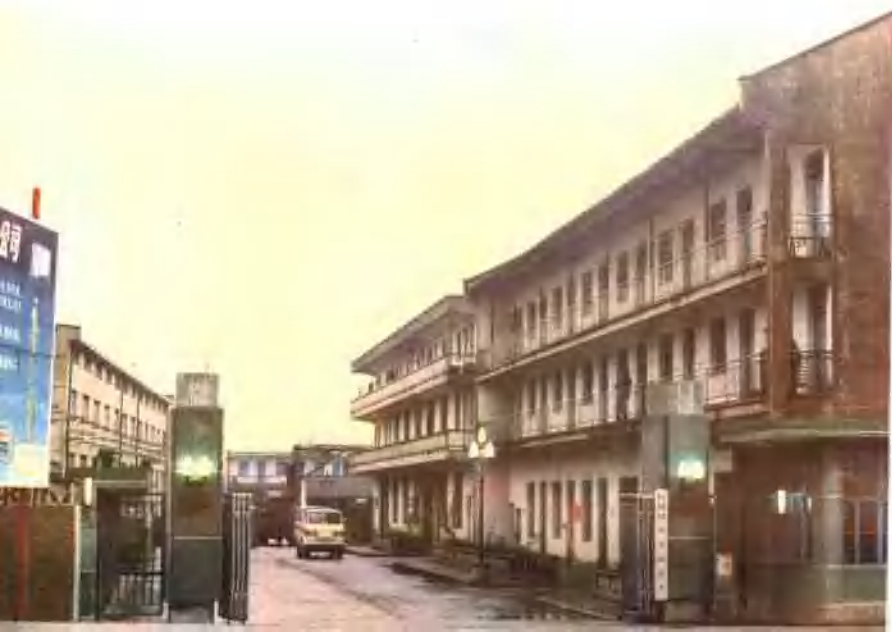
新寺机械厂门口及部分厂房
