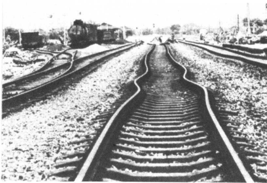
丰南火车站铁轨弯曲变形
