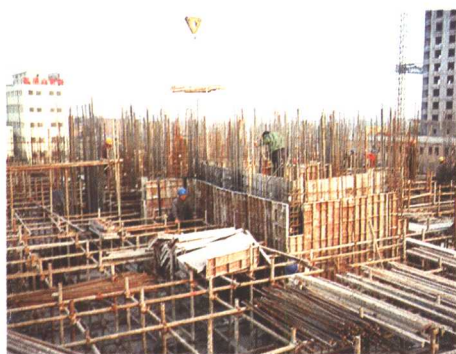
▲ 济宁市市中区第二建筑工程公司施工现场
