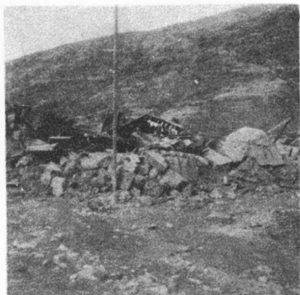
28. 瓦各公社“笨壳”房倒塌。
