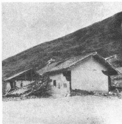
30. 侏倭贸易公司木排架节点拔榫，或榫头折断，造成落顶。
