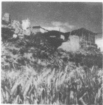
7. 侏倭村藏族房屋遭受严重破坏。
