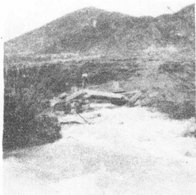
1. 折多塘附近石桥破坏情况。
