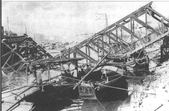
1927年新大桥(恒丰路桥)倒塌时的情景 ↓
