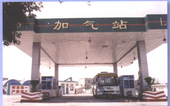
兰州市公交总公司建成的兰州市最大的汽车液化气加气站
