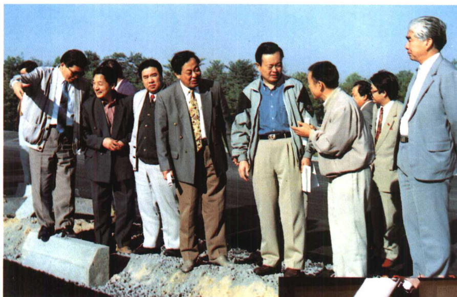
1995年9月27日，中共山东省委副书记陈建国（前排右三）视察东红公路建设工地。（公路局供稿）
