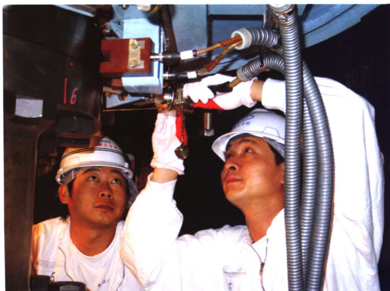
一回路主泵探头回装
