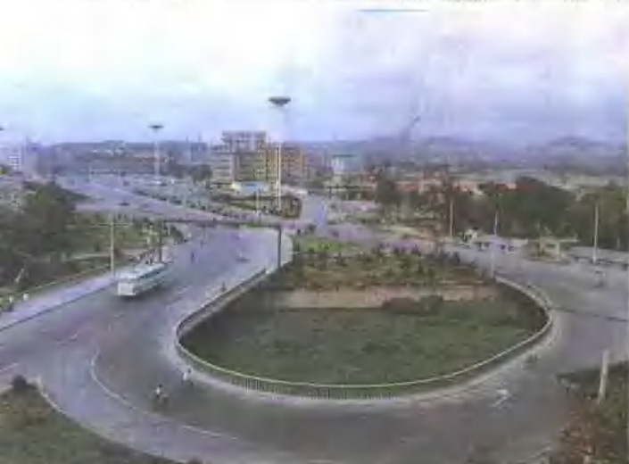
杭州路立交桥一瞥
