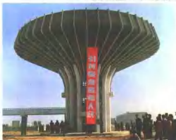
新建引黄水厂水塔
