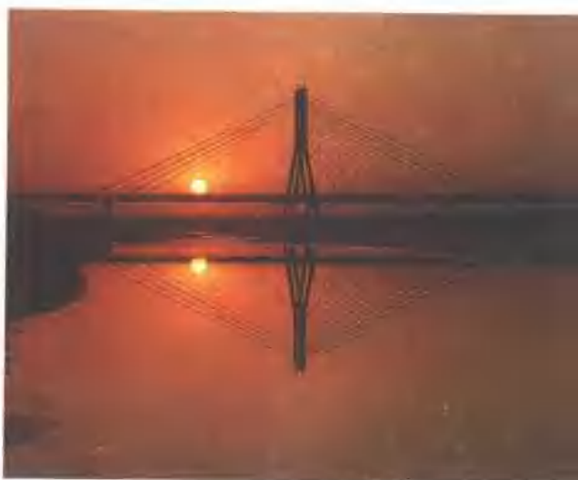
济南黄河公路桥
