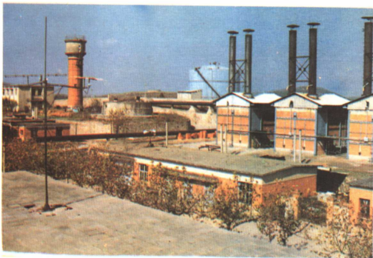
鲁宁输油线盱眙泵站
