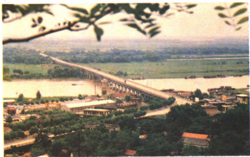
盱眙县淮河大桥全景
