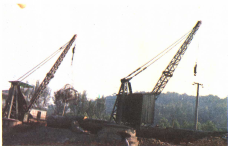
港务管理处作业区
