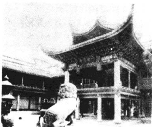
上海城隍庙戏楼
