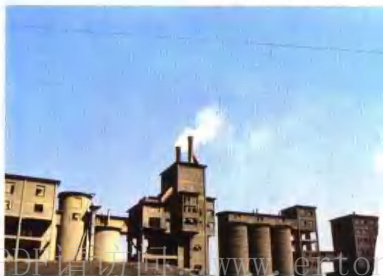
博兴县水泥厂生产线
