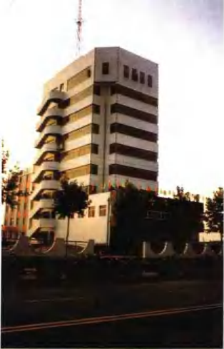
桓台县电业局电调楼
