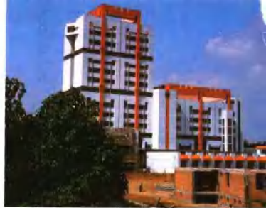
淄博市邮件处理中心（市“十佳”工程）， 唐山建筑公司承建
