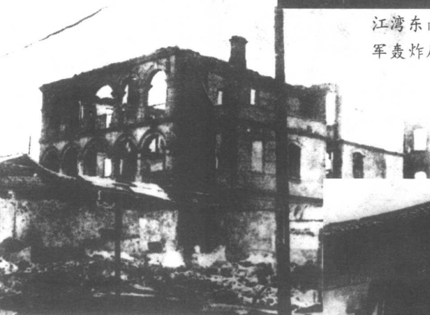
被炸的闸北工厂，只剩下断 壁残垣。
