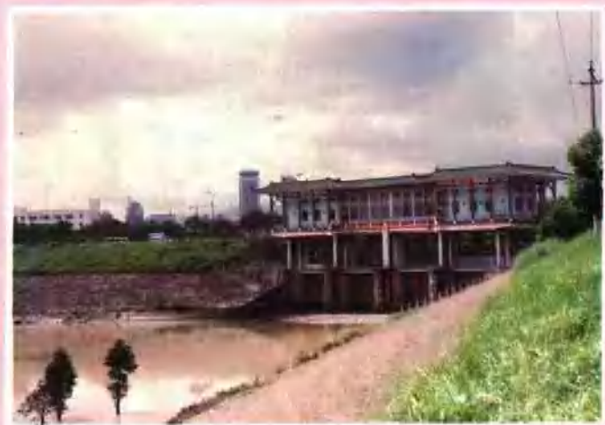
笋岗滞洪区泄洪闸
