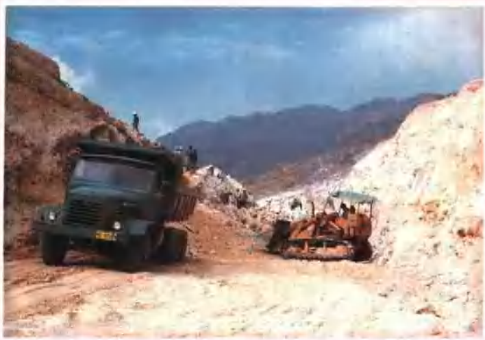
1984 年，开挖大坑水库溢洪道采用的机械
