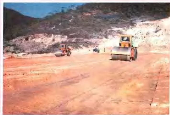
1984 年，大坑水库坝面采用的碾压机具
