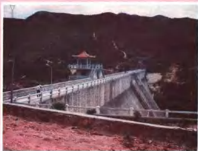
赤坳水库浆砌石重力坝
