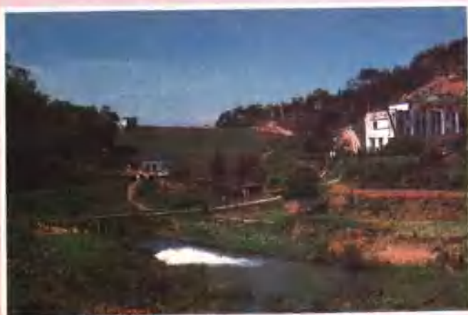
罗田水库坝后全貌
