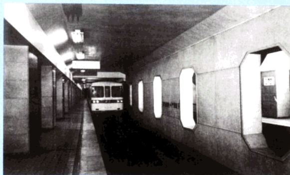
▲ 1969年10月通车的北京地铁（一线）是我国修建的第一条地铁，它的建成通车，极大地缓解了首都交通拥挤状况。
